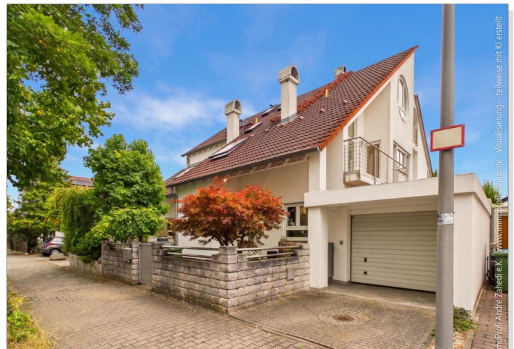
Hausansicht von Strasse
